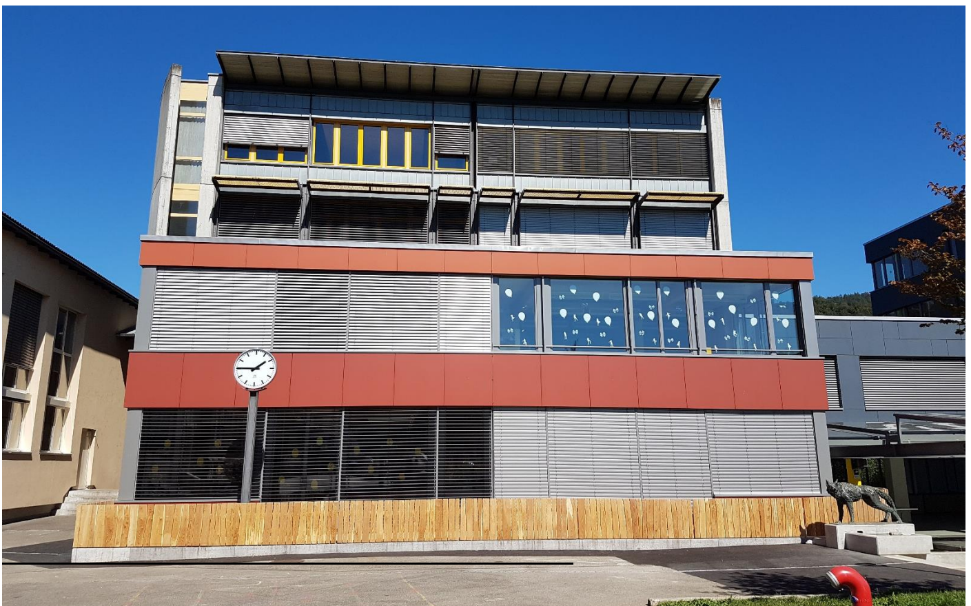
Der auf das Schuljahr 2020/21 in Betrieb genommene Erweiterungsbau des Schulhauses Bettenach
