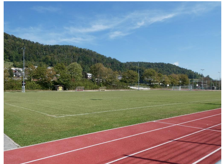
Sanierte Sportanlage Bifang
