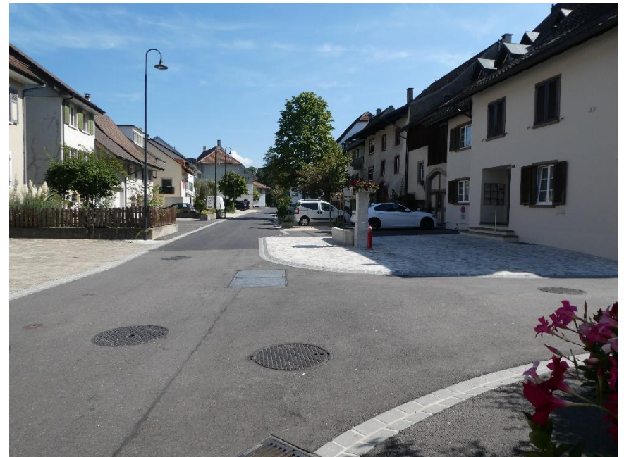
Blick in die sanierte Unterdorfstrasse.
